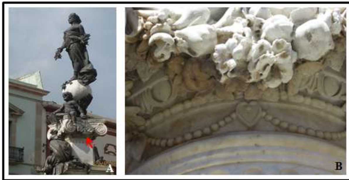
Figura 1. Estatua de la Paz, Guanajuato, Guanajuato. Note cambios de color y el deterioro (flecha) sobre los elementos arquitectónicos (B), por los microorganismos que forman biopelículas.
