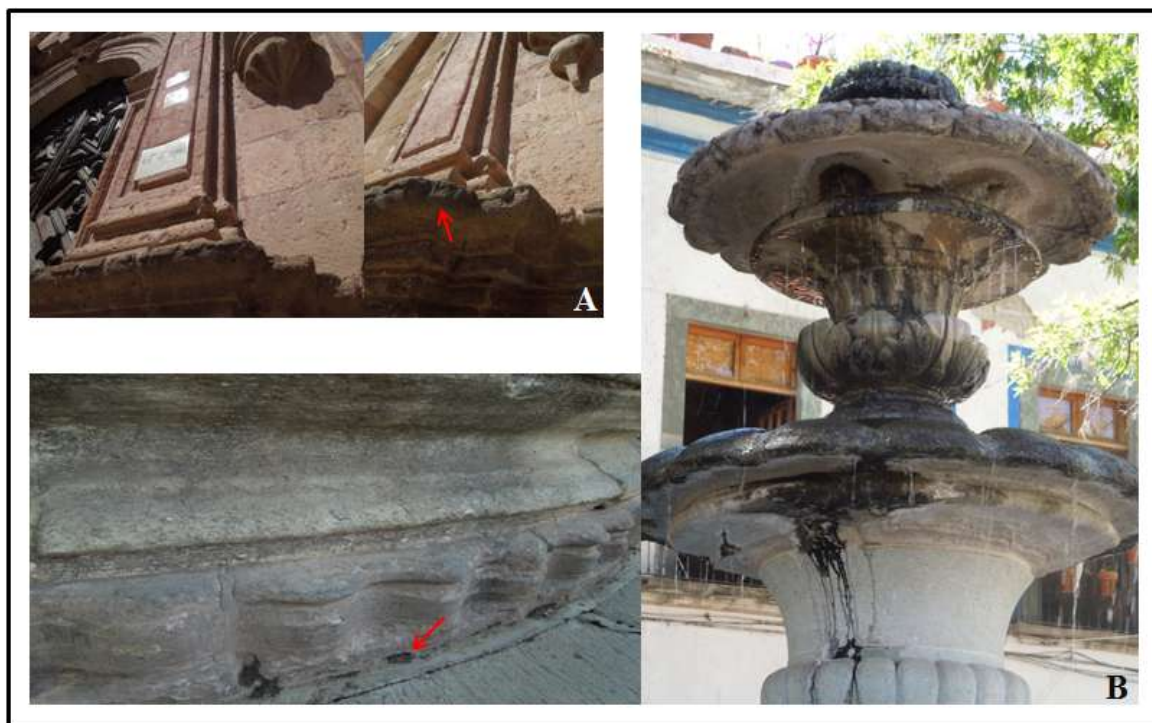
Figura 2. Iglesia de San Roque (A), Fuente de San Fernando (B), Guanajuato, Guanajuato. Es evidente el deterioro por factores ambientales y biológicos (flecha), entre ellos microorganismos que desarrollan biopelículas.
